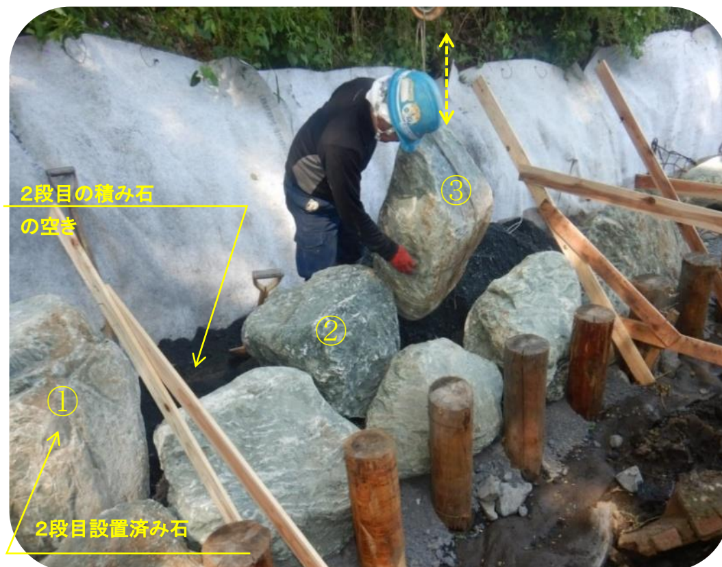
図4 石組護岸の施工状況
