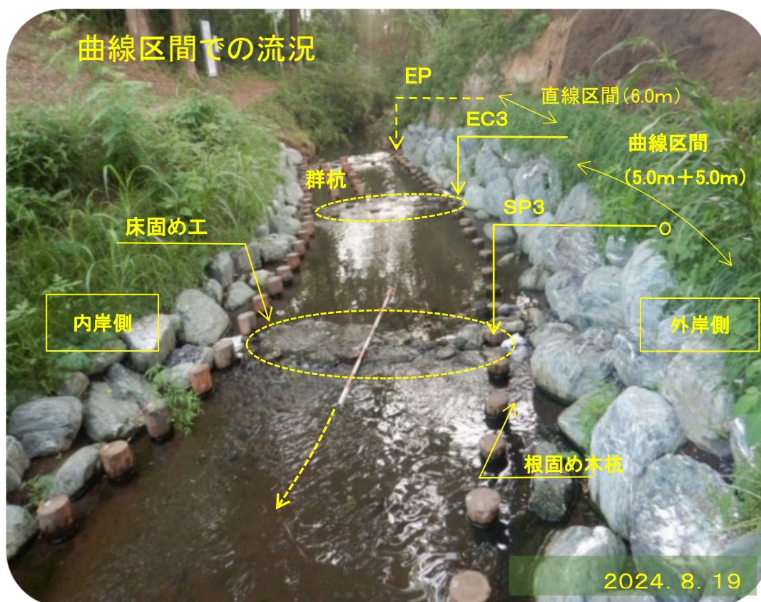
図6 石組護岸竣工後の流況
